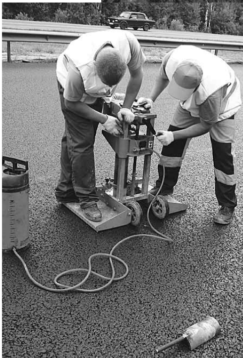
Объект строительного контроля – ремонт автомобильной дороги М-4 «Дон» км 71+350 – км 117+000
