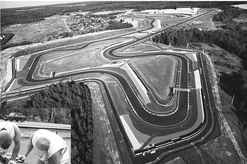
Объект строительного контроля – возведение гоночной трассы «Moscowraceway» на 95-км Новорижского шоссе
