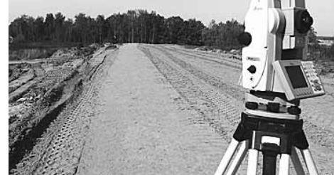
Объект строительного контроля – строительство автомобильной дороги «Ступино-Малино-Колупаново»
